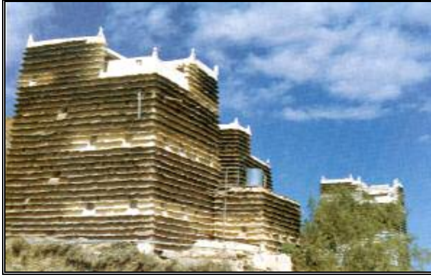
الشكل رقم (1-7) يوضح الطراز المعماري في المناطق الجبلية في منطقة عسير.
