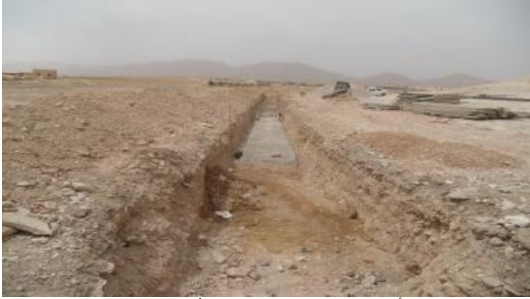
الصورة ( 3 ) أعمال الترميم لصب المجرى الأدنى وسقفه لفجارة عطا . المصدر : تصوير الباحث ، / 18 / 4 / 2011م .
