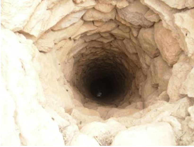
الصورة (4) بئر (فتحة تهوية أو نجمات) جدرانها مبنية بالحجارة في فجارة عين عطا وتظهر فتحة البئر من دون غطاء كما تظهر المياه في أسفل البئر .
