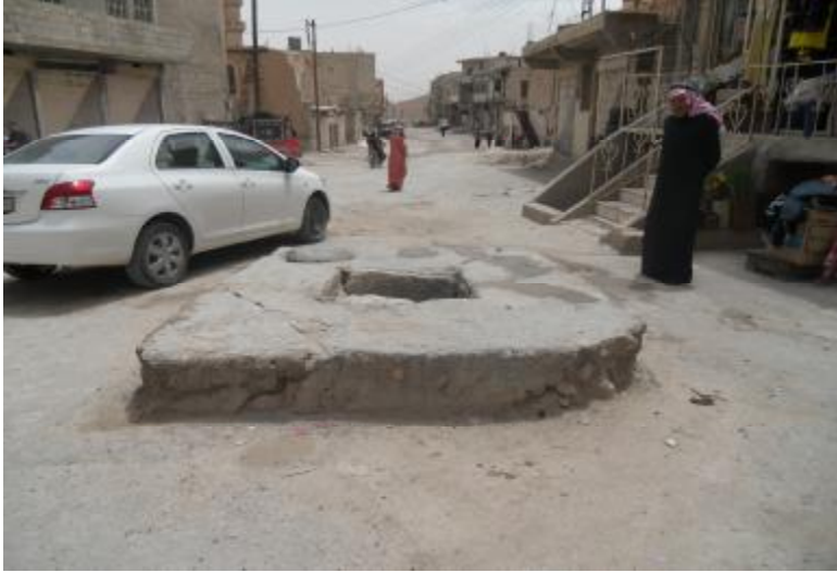
الصورة ( 20 ) فتحة بئر مكشوفة لفجارة رأس المعرة ويمكن سحب الماء منها، كما يوجد جرن صغير بجانب فتحة البئر يوضع فيه الماء لسقاية الحيوانات .
