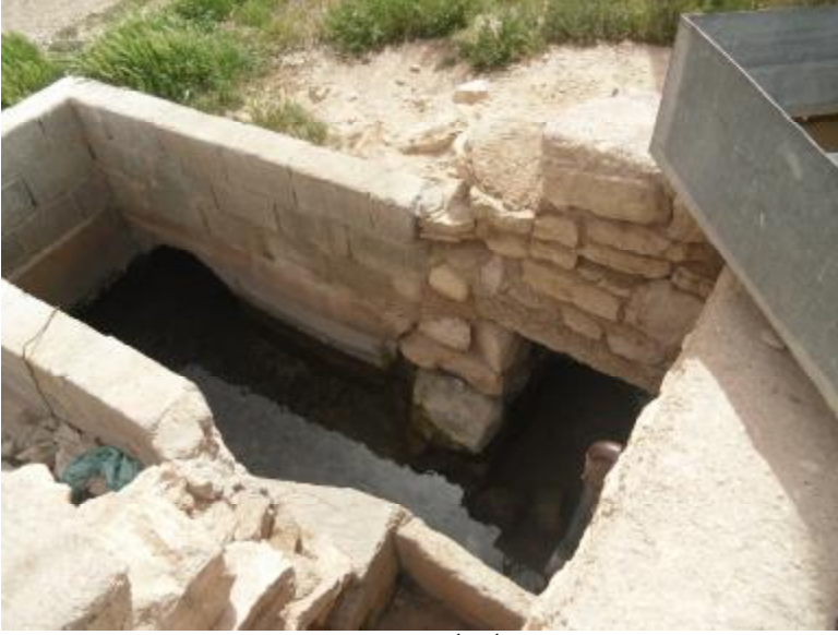
الصورة (9) مخرج فجارة البريكة إذ تُغلق لتجميع المياه في الأنابيب الإسمنتية التي رُكبت عام 1999 .
