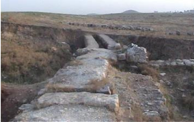
الصورة (5) تظهر قناة العاشق عند دخولها أفاميا
