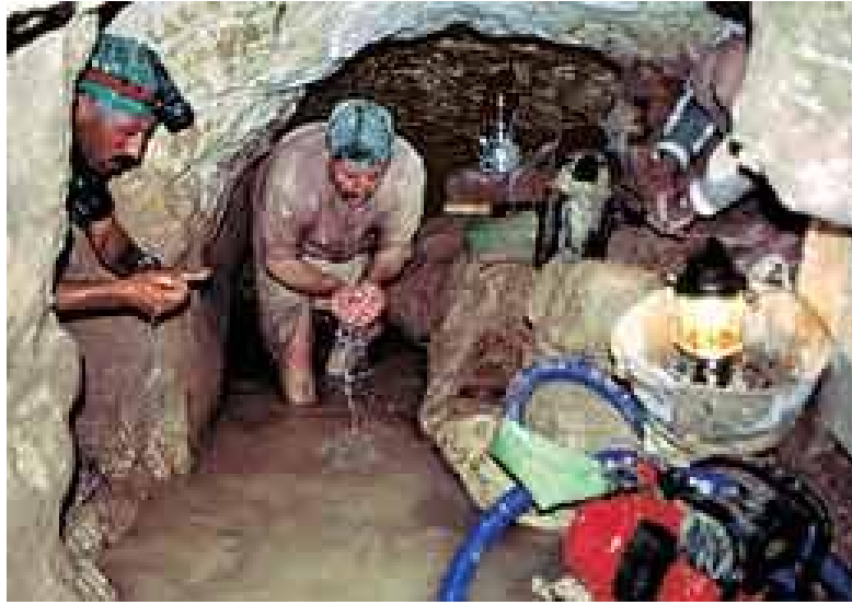
صورة (13) أعمال الغسيل والتنظيف داخل نفق فجارة في ريف حلب
