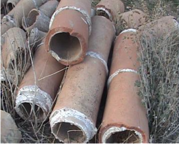
الصورة (10) أنابيب فخارية استخدمت لجر مياه قناة العاشق داخل مدينة أفاميا لإرواء سكان بعض القرى التي كانت تمر القناة بالقرب منها
