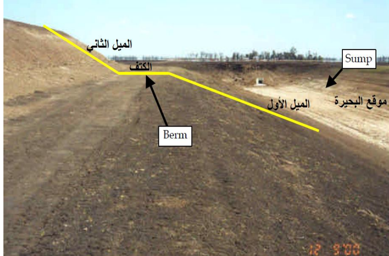
صورة 15. السطح الأمامي لأحد السدود الترابية مبنياً عليه الكتف
