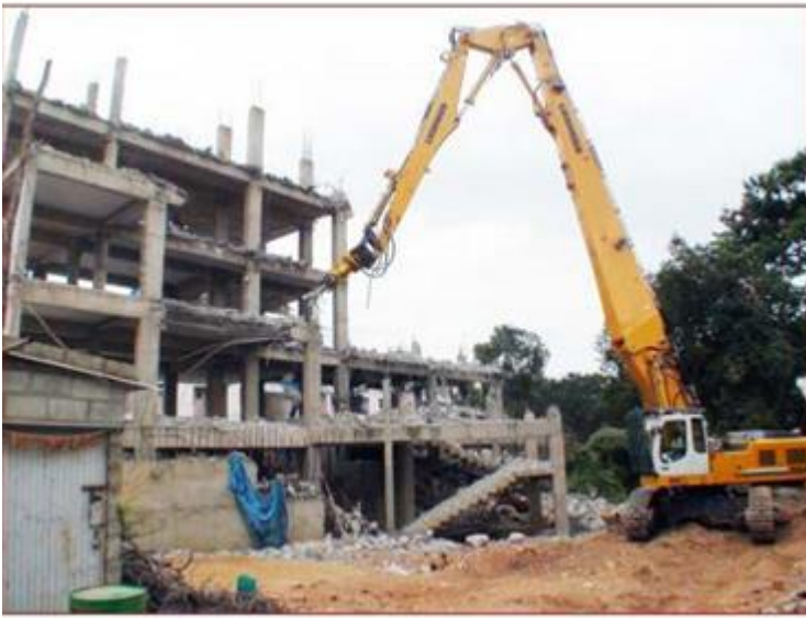
الشكل (2-2): الهدم بواسطة المطرقة الهيدروليكية
