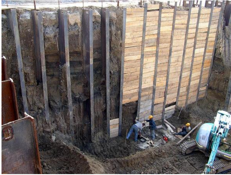
الشكل (3-6): هياكل التدعيم الظفرية الجانزية
