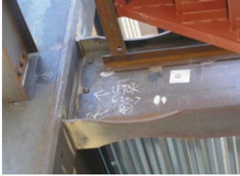
(الشكل رقم 23) مثال يوضّح خطأ في المنطقة المحميّة من الجائز (RBS) - ممنوع اللحام
