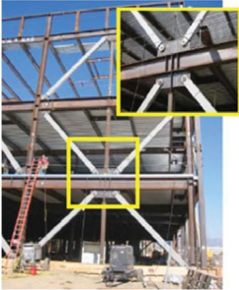
(الشكل رقم 10): شبكات التريبط الممنوعة من التحنيط BRB لتحقيق الفيوز الإنشائي
